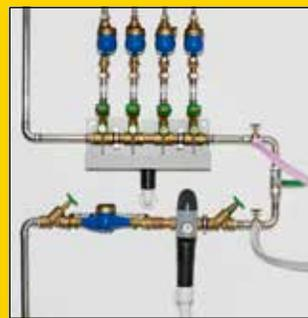
Flussaggio di impianti di acqua potabile (S/SL/SLW)
